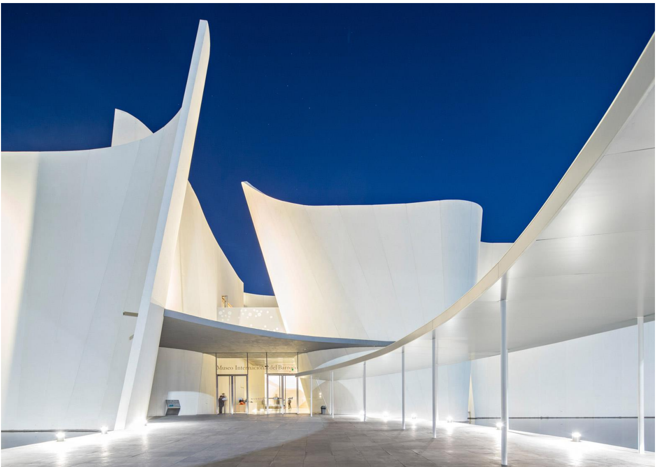
Museo Internacional del Barroco, Puebla, Messico (Architetto Toyo Ito & Associates)
