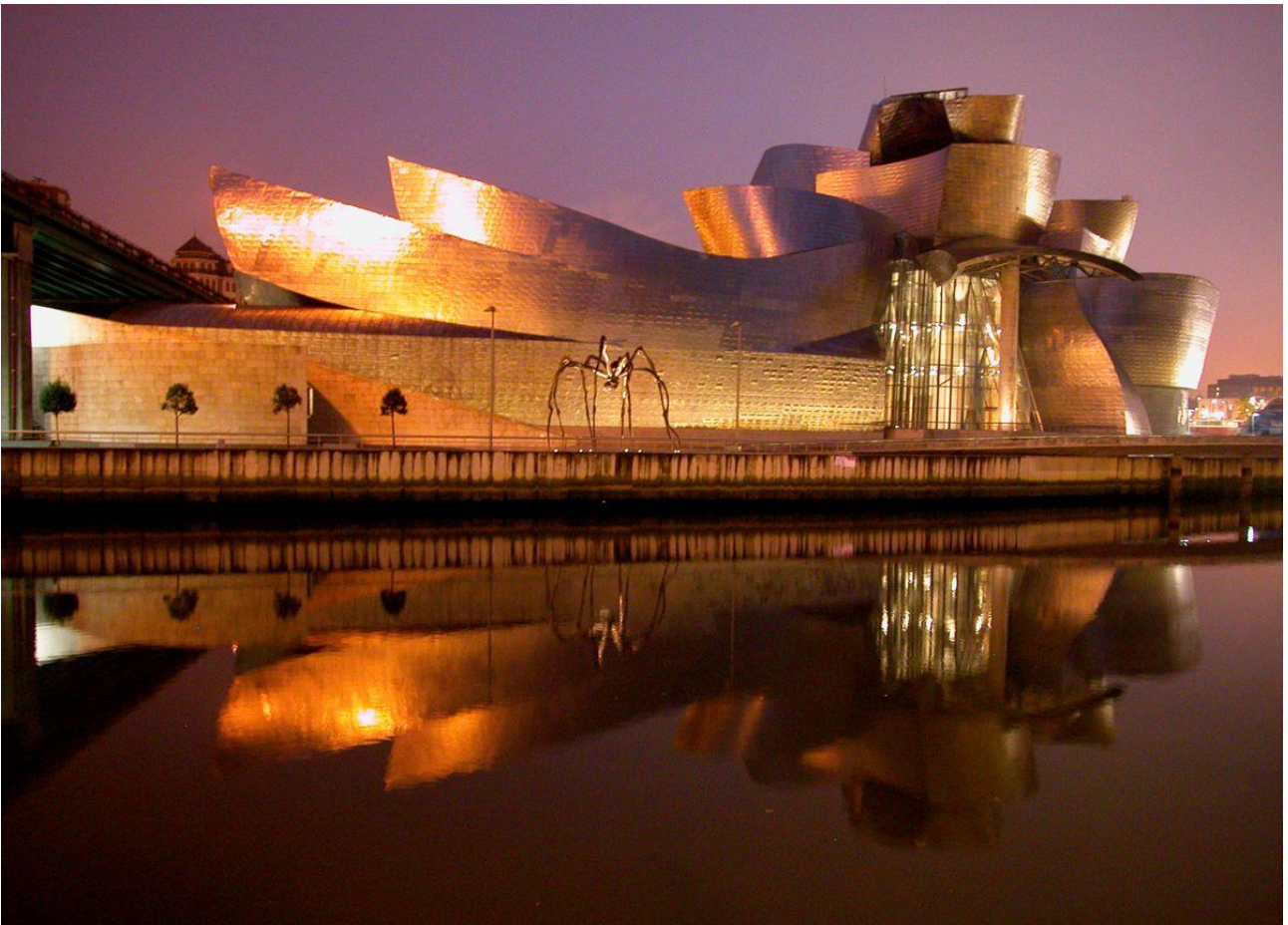
Guggenheim Museum, Bilbao, Spagna (Architetto Frank Gehry)
